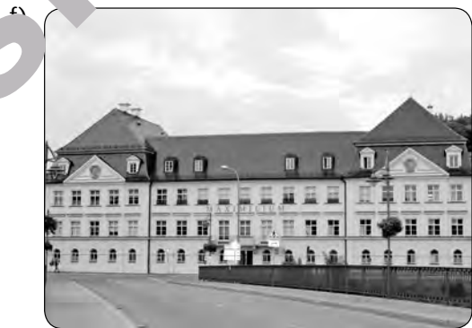
Entfernung bis zum Gebäude
